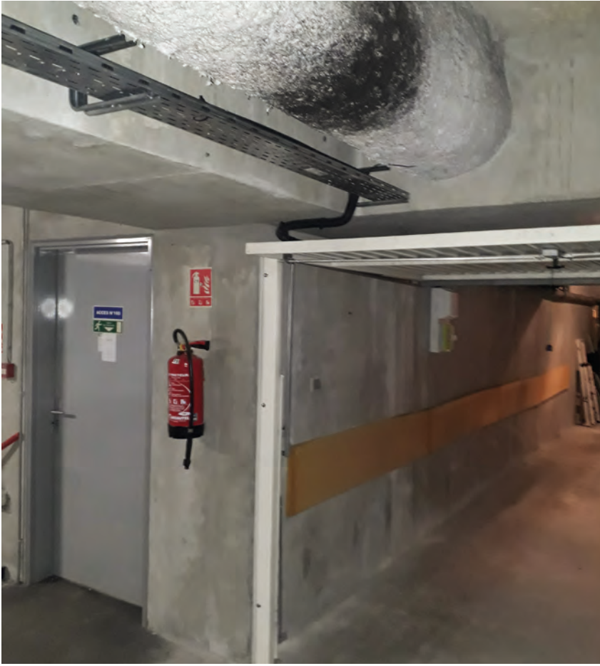
Dérivation individuelle raccordée à la colonne
