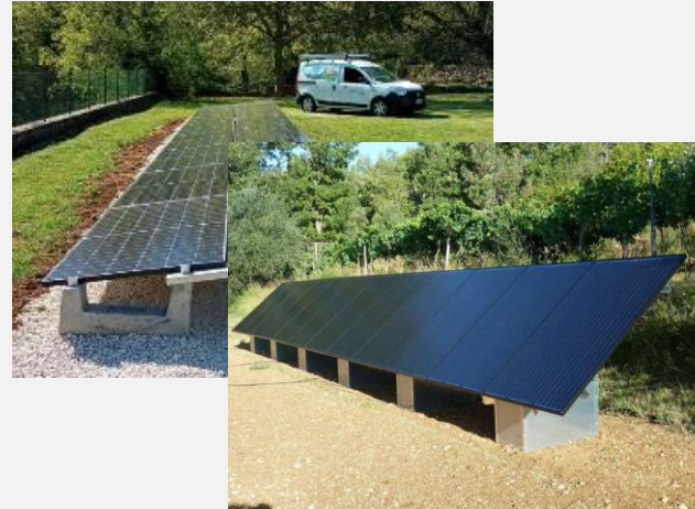
Structure au sol
